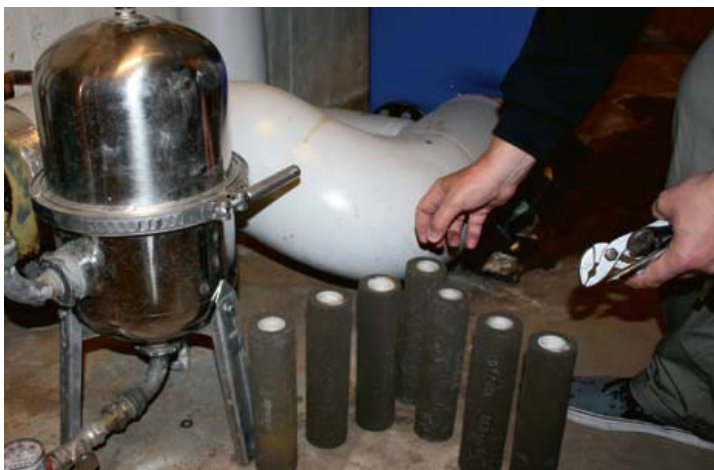
De sju filtren hos Brf Mysslingen motsvarar en yta av Sörmlands storlek
